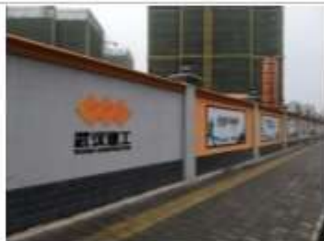
围挡、施工告示牌
