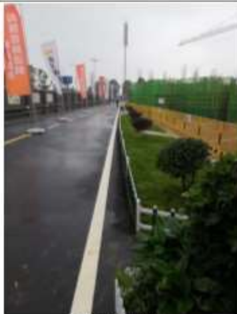
出入口及地面硬化
